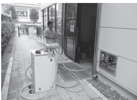
くん蒸ガスの注入
