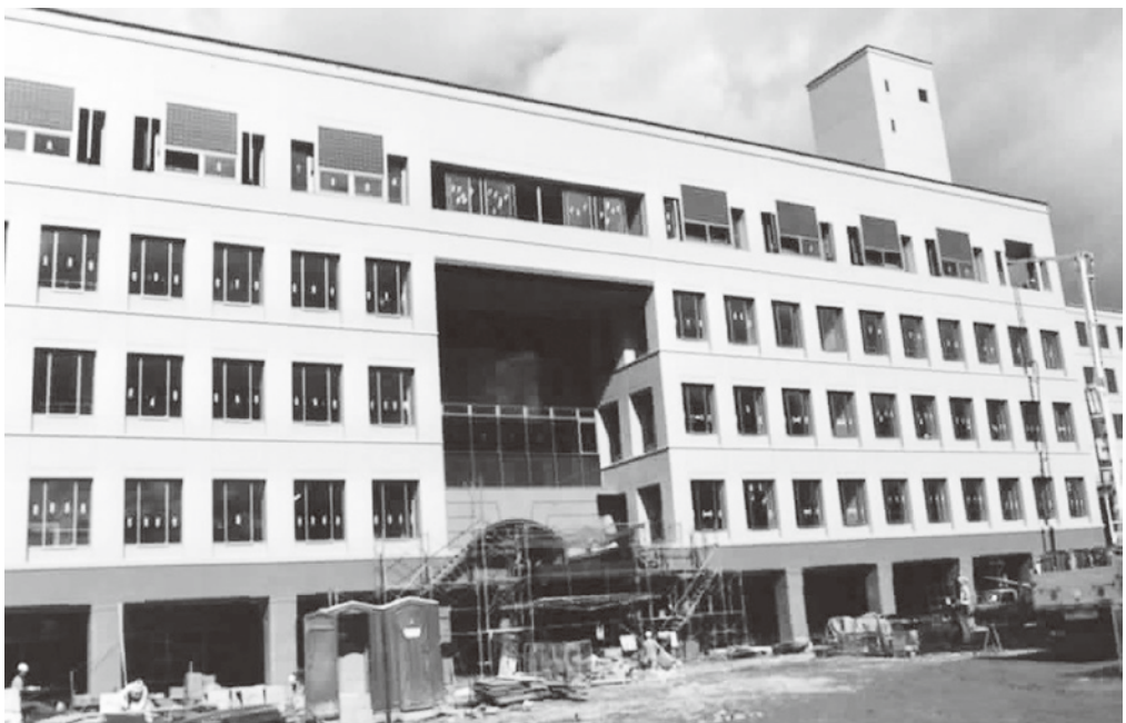
昭和 62 年建設中の 2 号館
