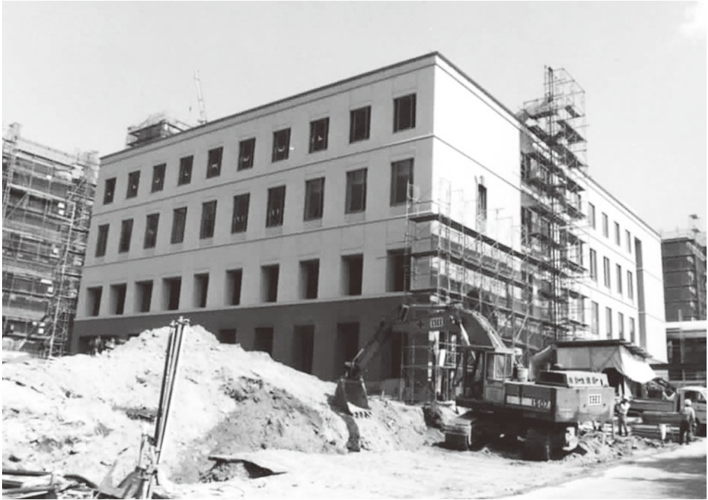
昭和 62 年建設中の 1 号館
