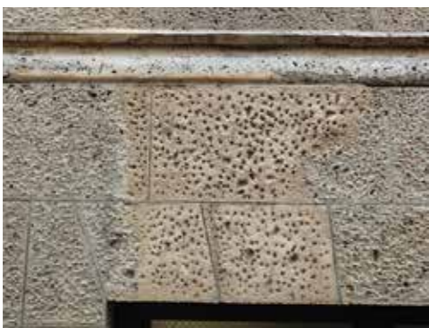
図4-9 西面の別の樹脂による補修跡
