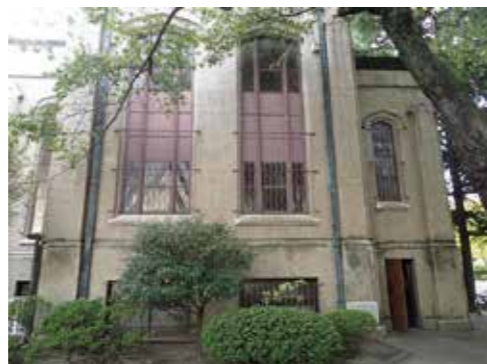
図4-6 東面の苔などの付着
