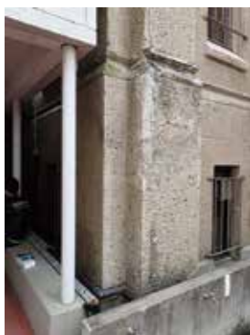
図4-10 南外壁の欠け
