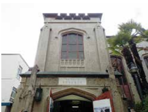
図4-3 礼拝堂エントランス上部階
