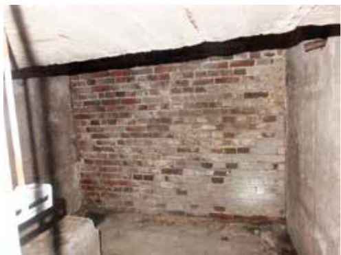
図2-9 礼拝堂～本館の地下隧道に残る煉瓦壁
