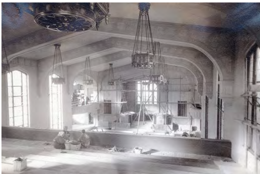
図5 ランカスター神学校に所蔵される礼拝堂の工事写真(東北学院史資料センター提供)
