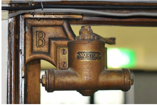
図 15 礼拝堂建具金物の全数調査
