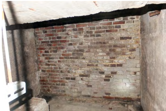
図8 大正時代の建造と見られる地下煉瓦壁
