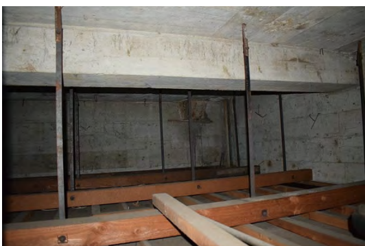
図13 礼拝堂階段室天井裏のコンクリート
