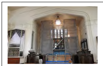
②パネル取り外し
