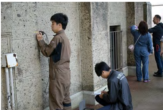
図11 礼拝堂外壁の超音波測定
